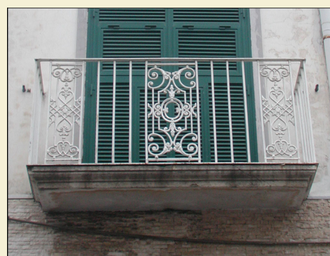
3. Ringhiera in ferro battuto con tre partiture di decoro
