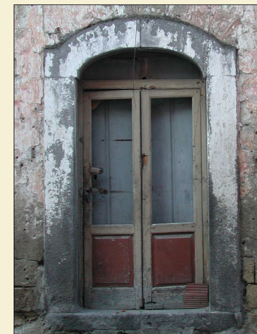
2. Porta in legno e vetro a due ante con sopralluce fisso
