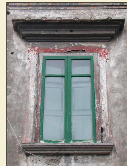
1. Infisso in legno con sistema oscurante interno: cromia originaria marrone
