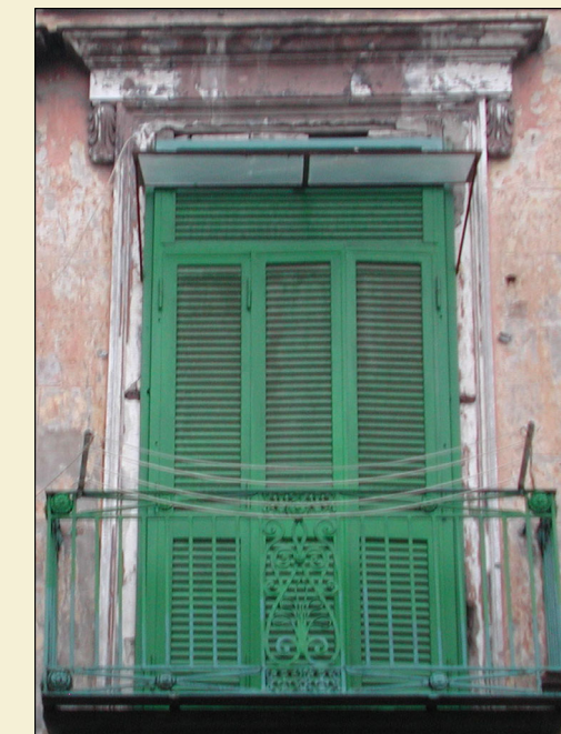
4. Persiane a tre ante semoventi con parte superiore fissa ad unica partitura
