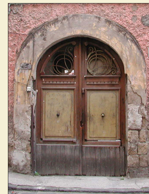
2. Portone a due ante con specchiatura in legno e decorazioni in ferro battuto
