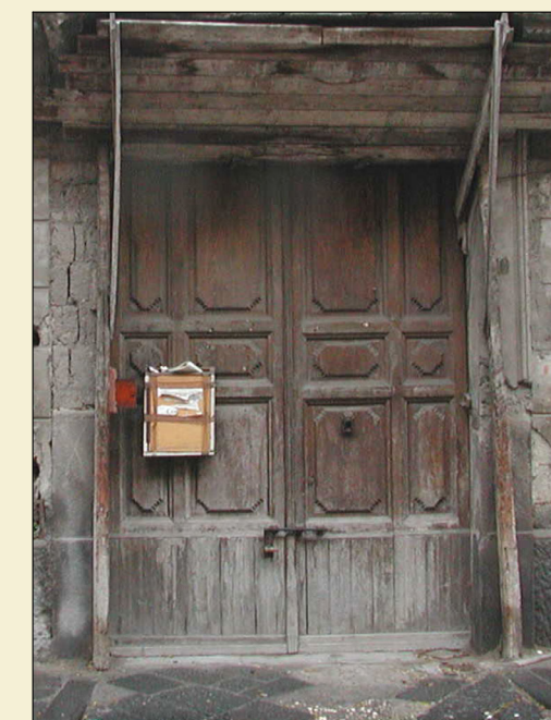
3. Portone in legno tinto marrone con bugne in rilievo
