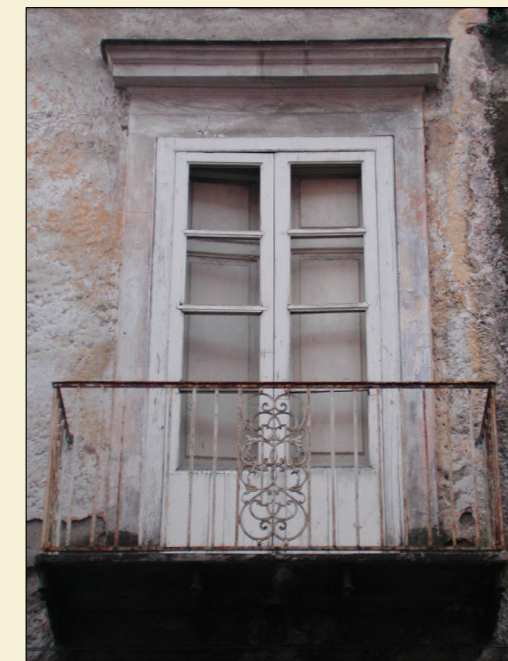
1. Balcone originario a due battenti in legno tinto bianco e vetro con sistema oscurante interno
