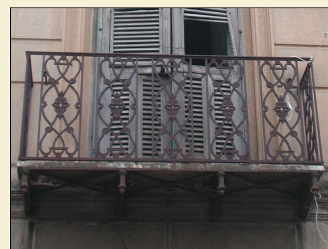
2. Ringhiera in ferro battuto con decori seriali
