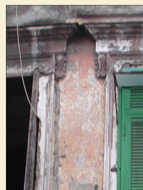
12. Il trattamento del fondo con una leggera listatura e tracce di colore rosso sull'originaria cromia gialla
