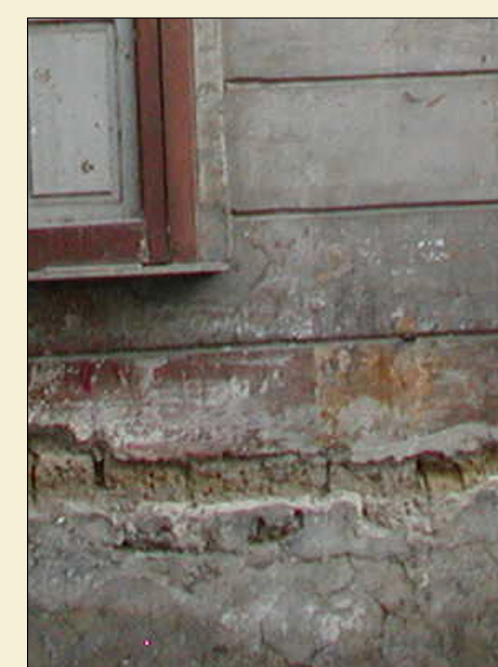
9. Stucco trattato a listatura ad imitazione della pietra lavica
