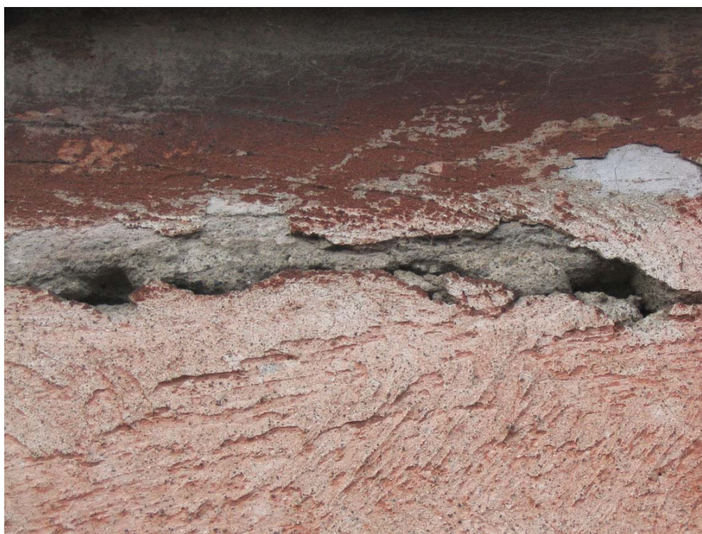
Figura 13 - "Le Palazzine": la presenza del rosso "cinabro" come uno dei cromatismi del partito architettonico di facciata.
