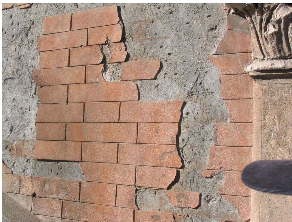
Figura 27 - "Ex Distillerie Esposito": particolare dell'intonaco ad imitazione del mattoncino.
