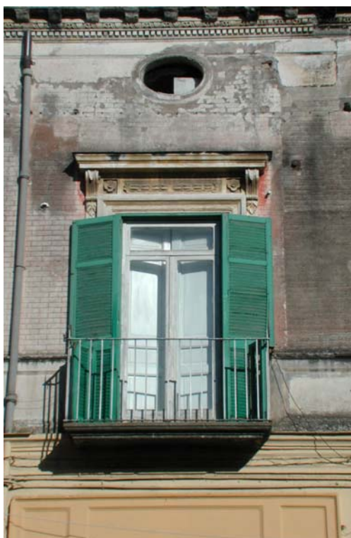
Figura 29 – Particolare di elementi in rilievo sulla facciata e tipologia di infisso esterno con sistema di oscuramento.
