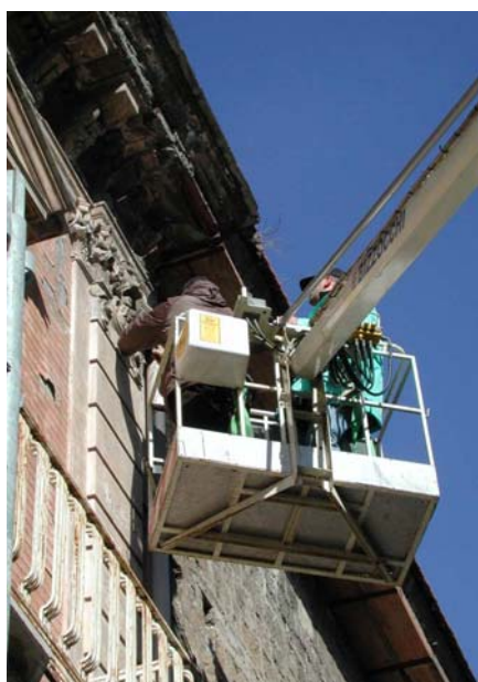
Figura 11 - Operazioni preliminari per il prelievo delle campionature d'intonaco.
