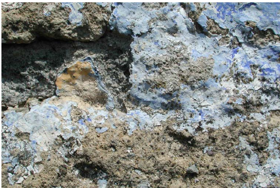
Figura 26 - Le tracce originali del colore azzurro che evidenziano la presenza di "turchese".
