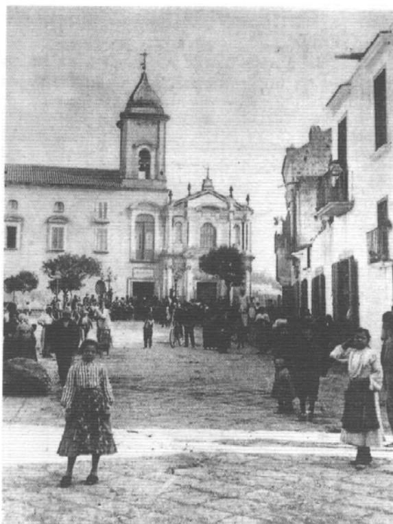
Figura 17 - Chiesa e convento della B. V. del Carmine, attuale Piazza Municipio. Foto storica, Archivio privato.
