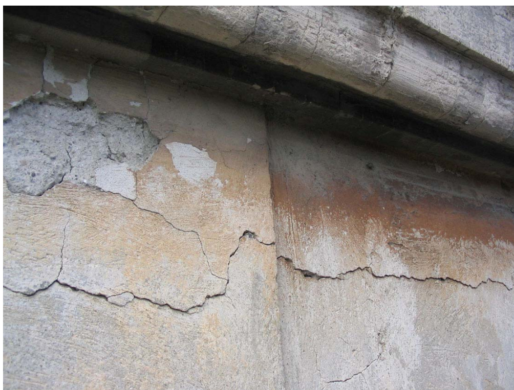
Figura 14 - "Le Palazzine": particolare del cornicione con l'evidenziazione dell'alternanza nel partito architettonico di facciata dei cromatismi del giallo chiaro e del giallo ocra.
