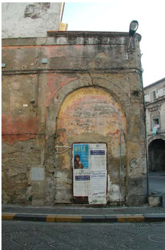
Figura 35 - La stratificazione cromatica sugli edifici del centro storico, Via Felice Pirozzi, angolo Via Roma.
