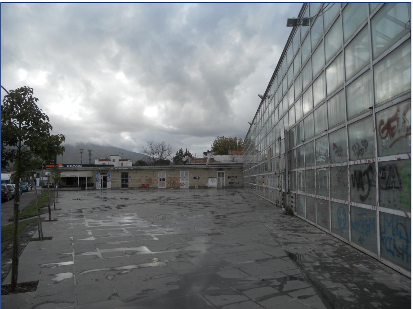
Piazza esterna su via Ghandi, sono visibili sullo sfondo i locali commerciali
