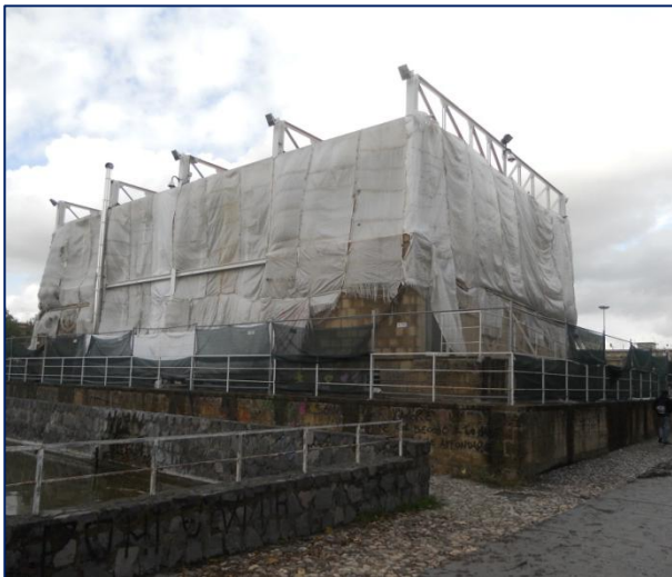
Vista sul retro dell'edificio
