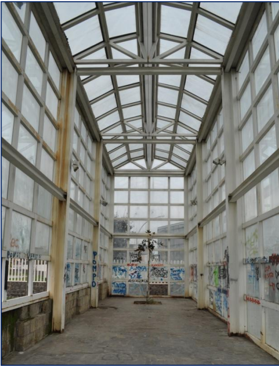
Vista interna all'edificio vetrato
