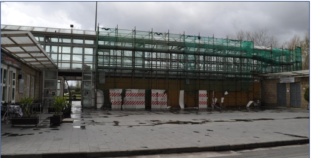
Prospetto sulla piazza esterna: si legge lo stato di degrado e di abbandono complessivo
